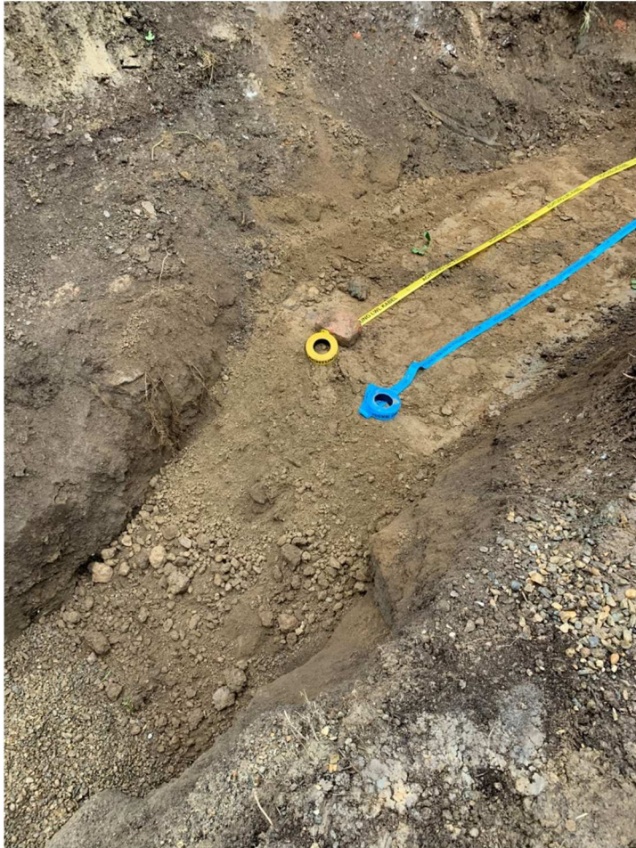
Künettenverfüllung mit Warnband-Einlage auf Grundstück Nr. 1723, KG Stögersdorf
