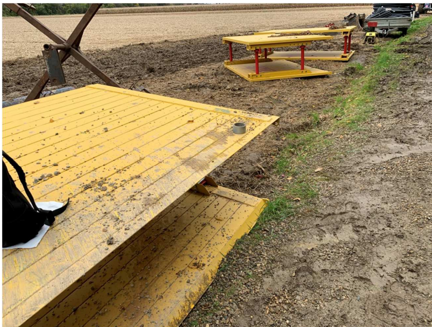
Verbauplatten zur Künettensicherung
